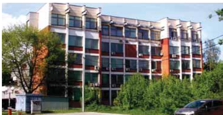
Zgrada Ekonomskog fakulteta (završna etaža naknadno dograđena)
