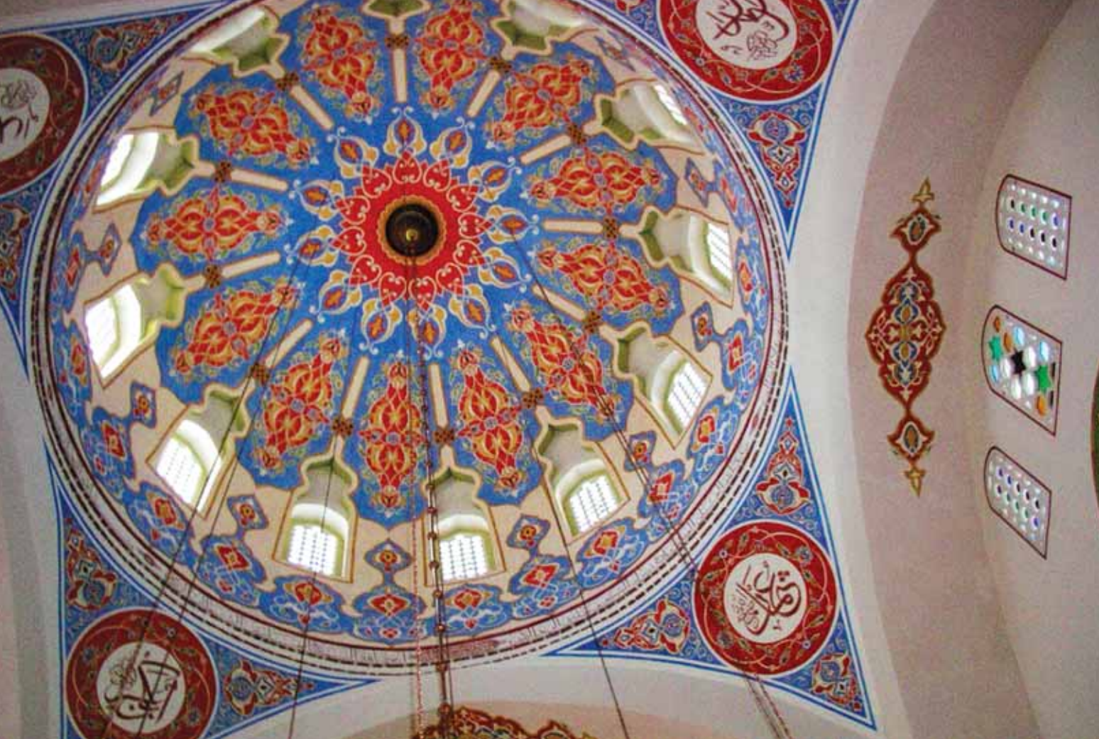
Arabeska / Oslikanje kupole i pandantiva džamije Ferhadije
