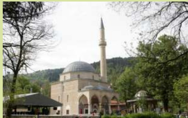
Obnovljena Aladža džamija, Foča
